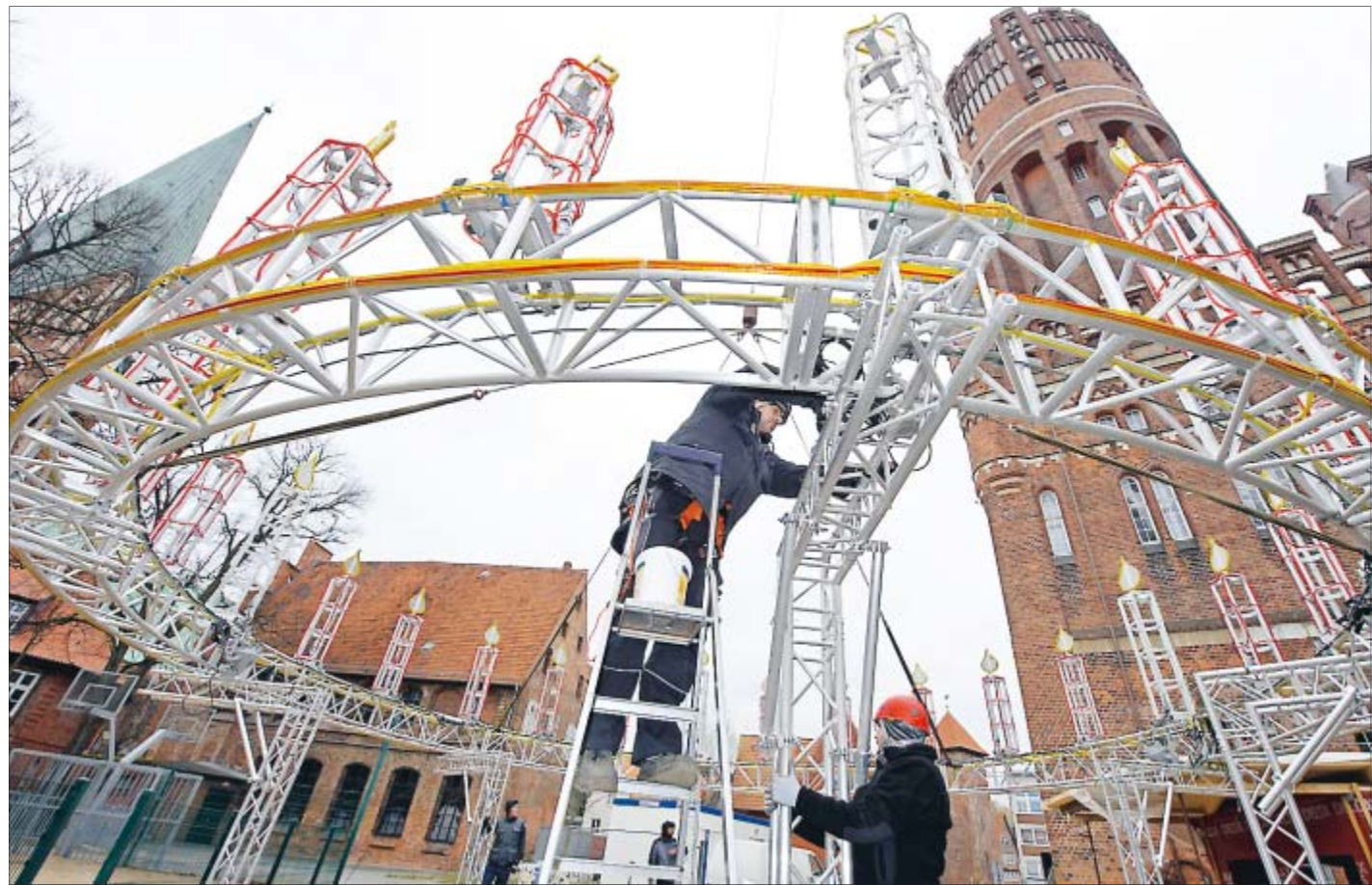
Arbeiter machen den Adventskranz startklar. Wenige Minuten später hievt der 250-Tonnen-Kran die Last auf 56 Meter Höhe. Dort können die Lüneburger die Kerzen in den kommenden fünfzehn Wochen zum Leuchten bringen.
