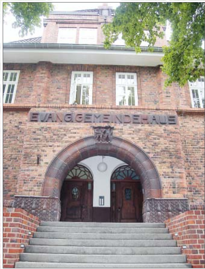
Nach mehr als einem Jahr sind die Sanierungsarbeiten am Haus der Kirche abgeschlossen, und das wird am Freitag, 11. Juni, mit einem großen Fest gefeiert. Foto: bj
